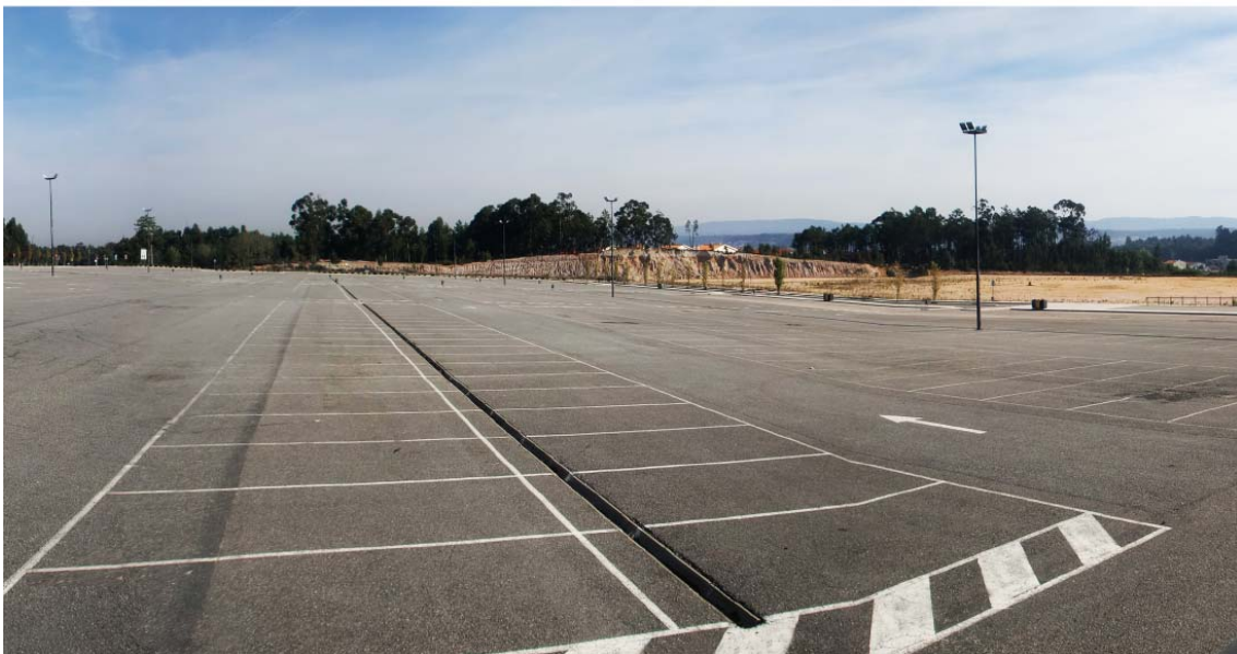
Fig. 43 – Edifício da área comercial, anel de circulação pedonal e estacionamento exterior [Fonte: Autor]
