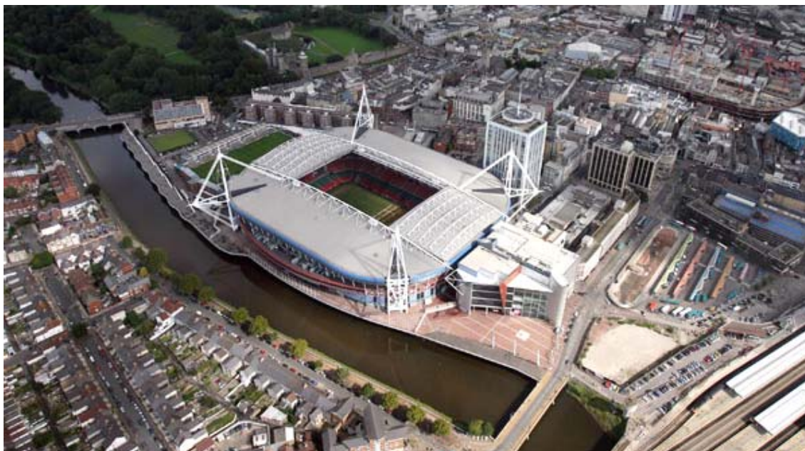
Fig. 9 – Inserção urbana do Estádio Millennium, em Cardiff [Fonte: millenniumstadium.com]
